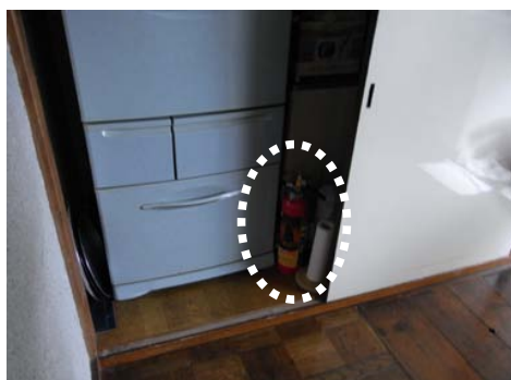
台所に設置された消火器
