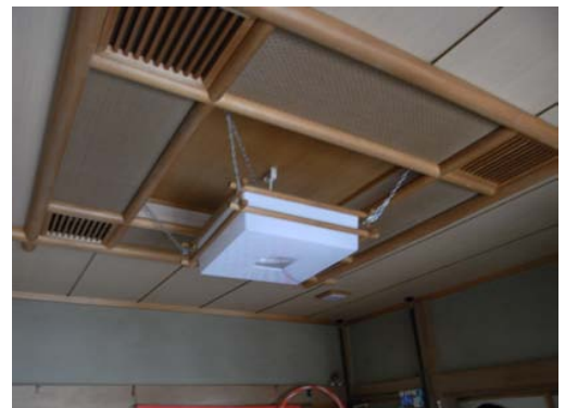
転落防止措置をした照明器具
